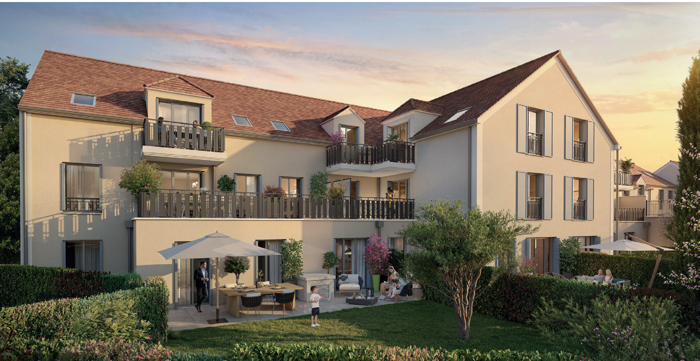
Bâtiment Charme - côté jardin - 20 appartements
