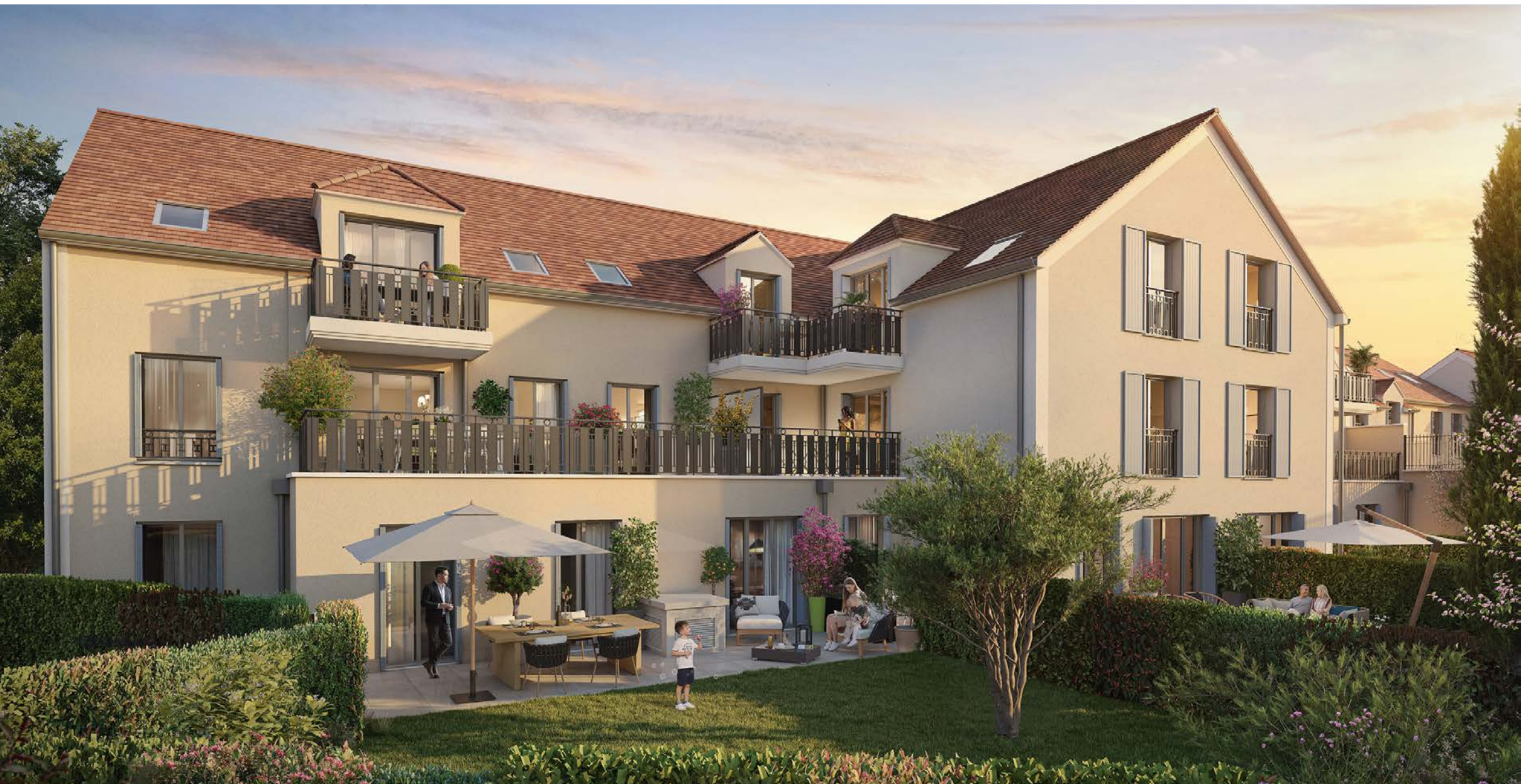
Bâtiment Charme - côté jardin - 20 appartements
